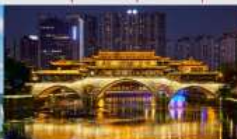
สะพานอันชุน
